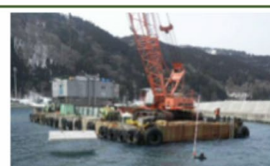
漁港ナマコ養殖システム ナマコを閉じ込め養殖する ための空気だまりを持つ ブロックの開発と実証
